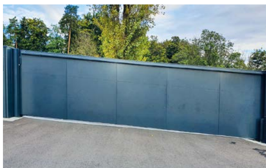
Schrägbau-Schiebetor mit Glattblechfüllung
